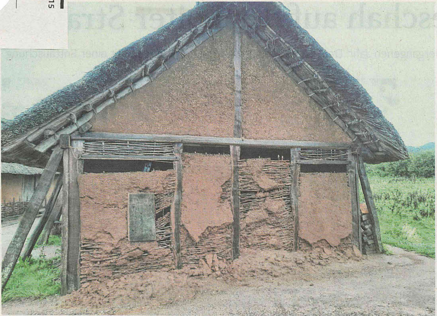
Regen und Wind haben dem Lehmfachwerk der Wikingerhäuser zugesetzt.
